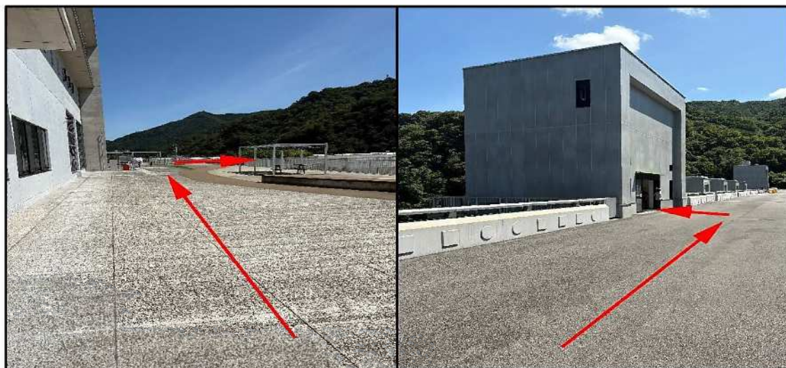
↑ 経路④ やんばダム資料館裏からエレベーターへ
